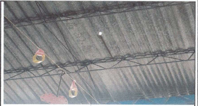
Foto 2: sustitucion de lamina
