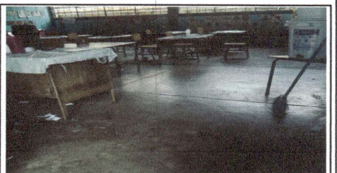
Foto 6: sustitución de piso.
