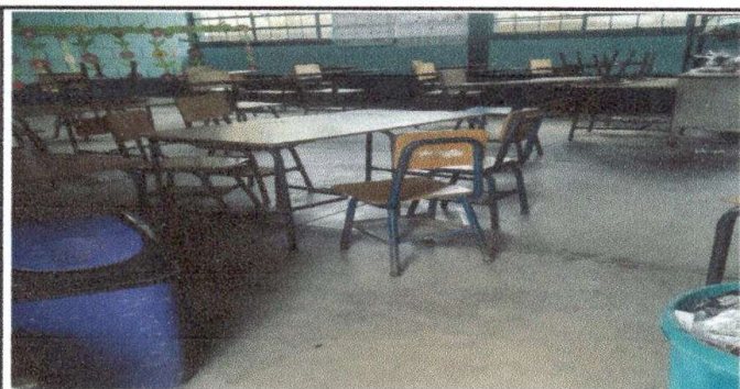
Foto 5: sustitución de piso.
