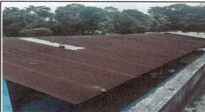
Foto 3: sustitucion de lámina.
