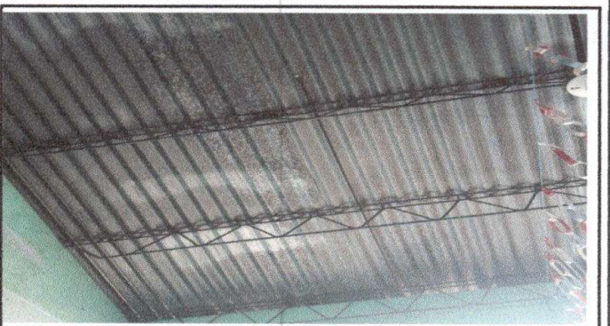
Foto 4: sustitucion de estructura de metal
